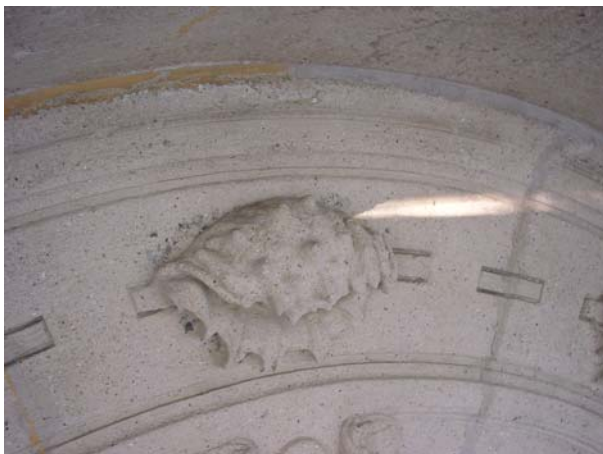
Stuccature e risarciture delle lacune con resina epossidica rinvenute a seguito della pulitura (Impresa IMG srl – Milano)
