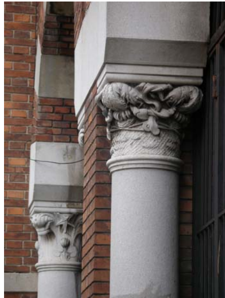
Carlo Pergoli, Pescheria comunale, Zagrebačka 17, facciata d' ingresso, dettaglio
