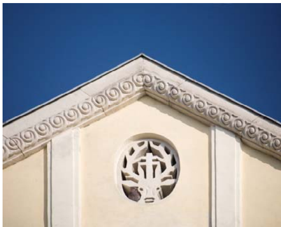
Lorand Kismarty Lechner, Ufficio forestale, Bulevar oslobođenja 23, dettaglio della facciata d'ingresso
